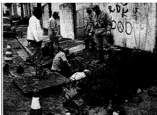
Figura 12 – Limpeza de Boca de Lobo.
