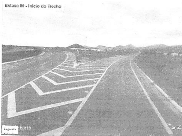
Foto 01 – Estaca 00 - Início do trecho na interseção com Av. do Contorno.
