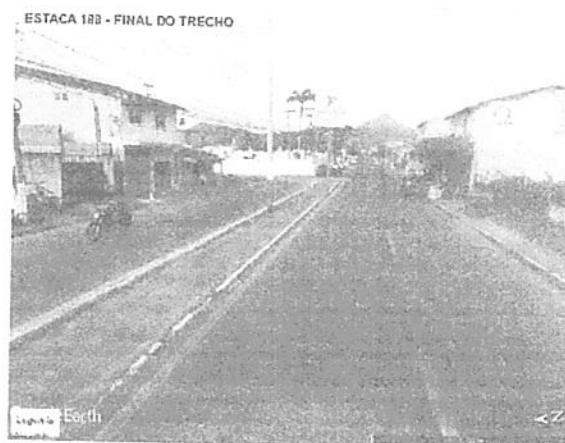
Foto 06 – Final do trecho.
