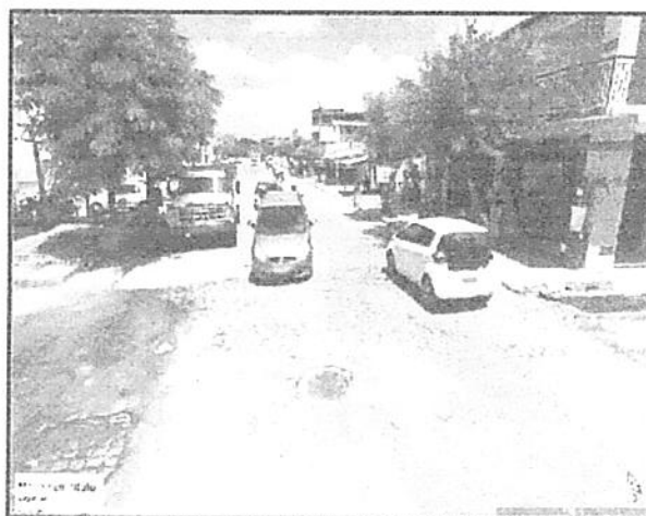
Foto 2 – asfalto danificado e calçamento exposto.
