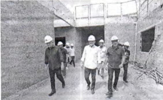
Com a ampliação, o edifício, que tinha uma área de 4.545m², passará a ter 6.300 m²
