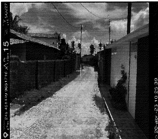
Foto – Trechos já existente em piçarra.
