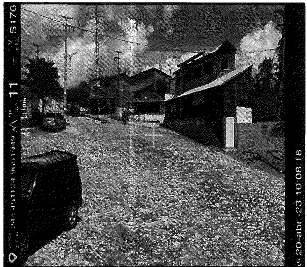
Foto – Trechos já existente em pedra tosca.
