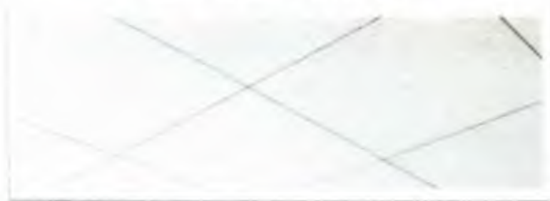
Foto 25 – Forro em Placas de Fibra Mineral
