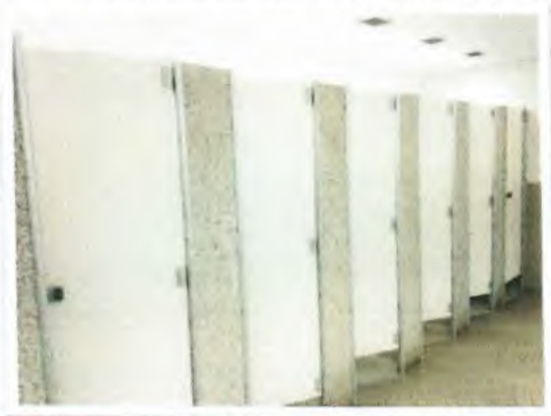
Foto 33 – Divisórias de Granito Cinza Andorinha e Portas em Chapa de Madeira
