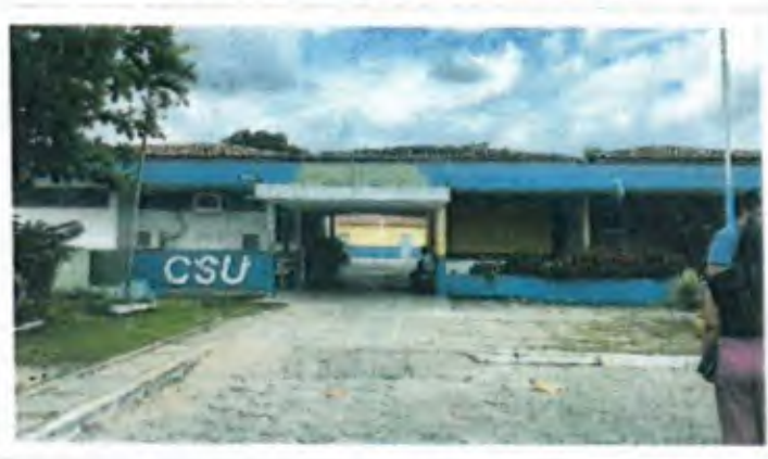
Foto 12 – Edificação para ser demolida - CSU.
