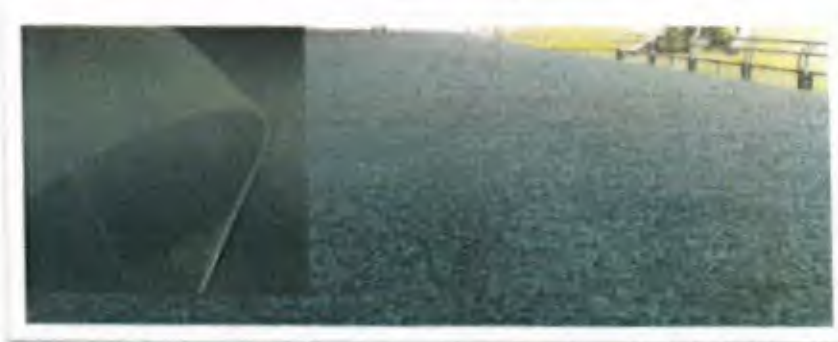
Foto 20 – Piso com Forração Têxtil
