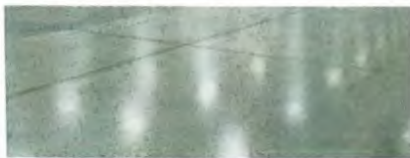
Foto 19 – Piso Industrial Polido com Juntas Plásticas
