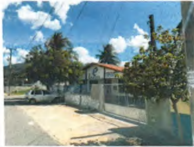
Foto 10 – Calçadas e Muros Externos.
