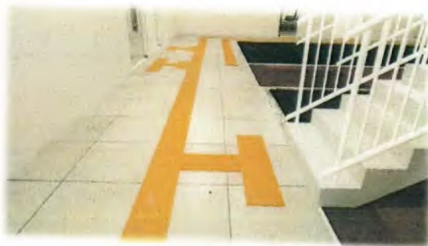
Figura 23 – Volumetria dos Acessos com Piso Tátil - SASDH (Acessibilidades conforme ABNT NBR9050 / NBR 16537)
