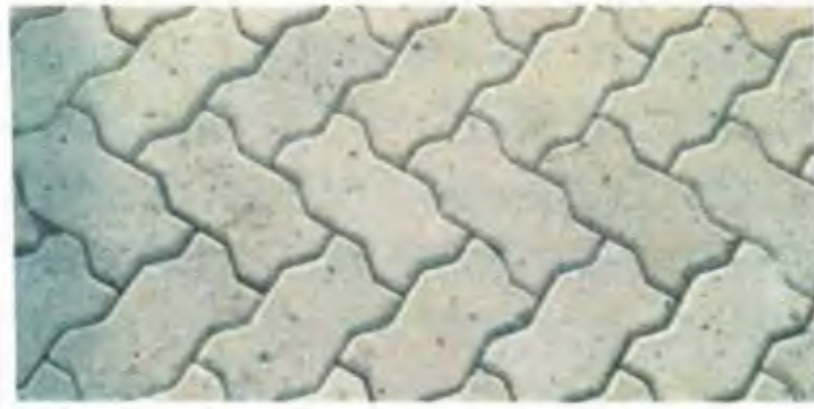
Foto 22 – Piso Pré-Moldado Articulado Intertravado 16 faces
