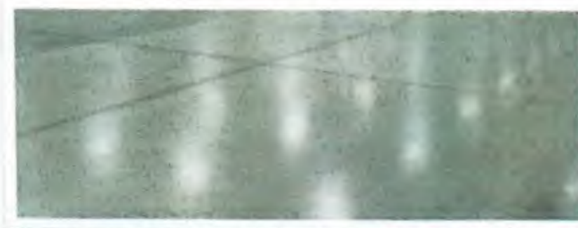
Foto 21 – Piso Industrial Polido com Juntas Plásticas
