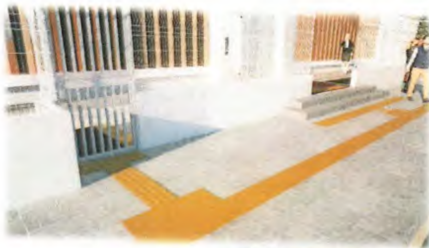
Figura 22 – Volumetria dos Acessos com Piso Tátil - SASDH (Acessibilidades conforme ABNT NBR9050 / NBR 16537)
