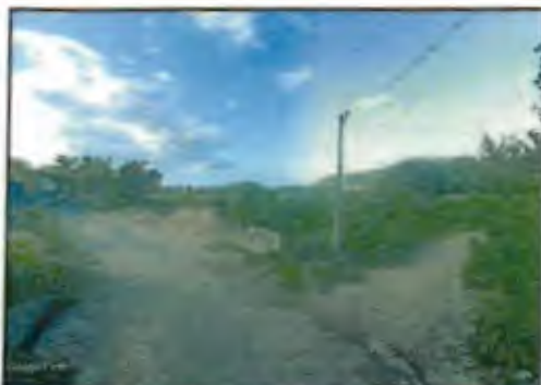
Foto 01 (Estaca 00) – Início do trecho 01 da urbanização do Canal Riacho das Almas na Rua do Açude das Nações.
