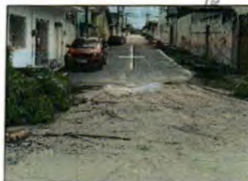
Foto 05 – Final do trecho 02 da qualificação urbana do Canal Riacho das Almas
