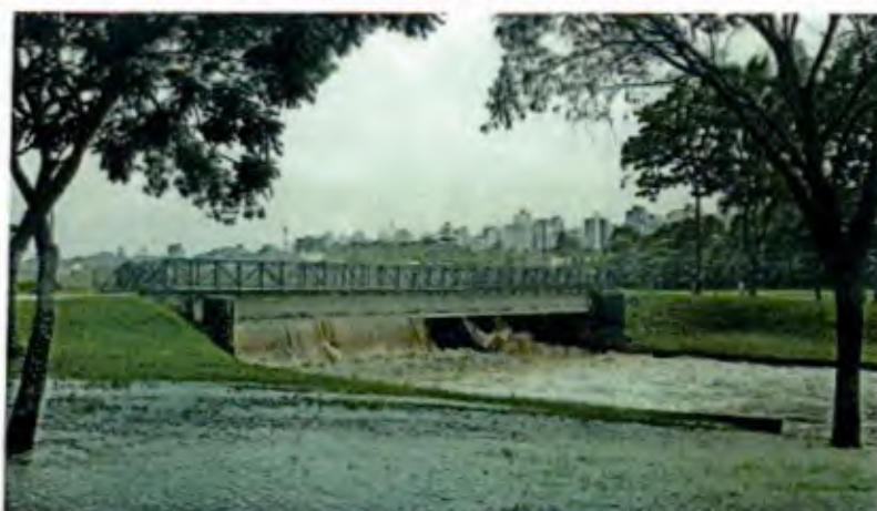
Figura 33 – Canal urbano em regime supercrítico do Parque Bareguí em Curitiba-PR.
