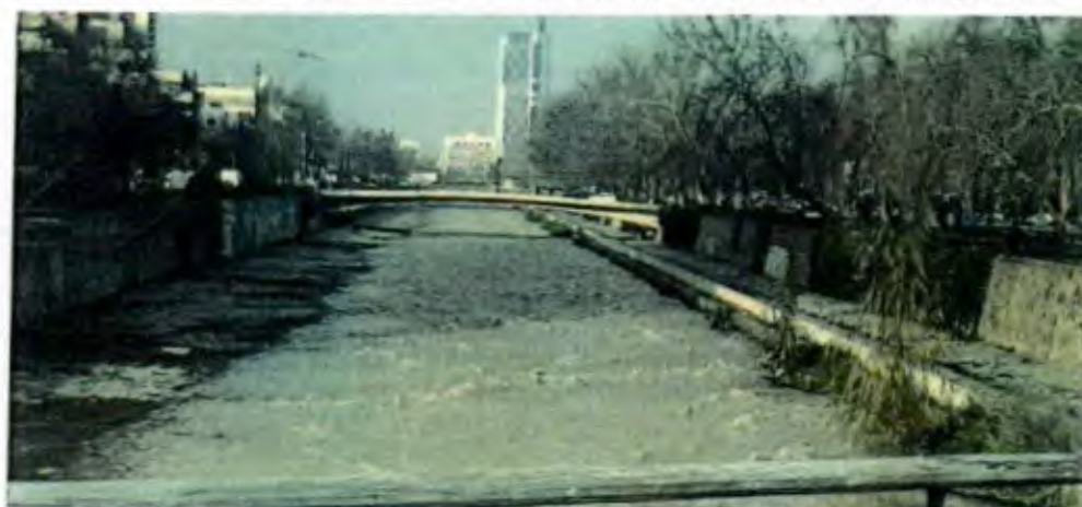
Figura 34 – Canal em regime de escoamento supercrítico no centro de Santiago, Chile.
