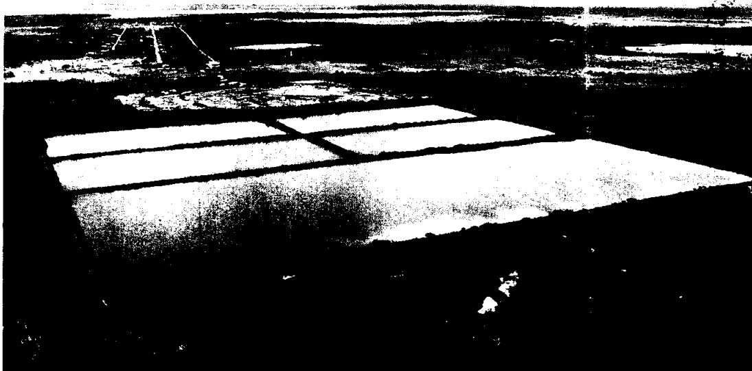
Figura 10 – Estação de Tratamento de Esgoto (ETE) Existente do SES
