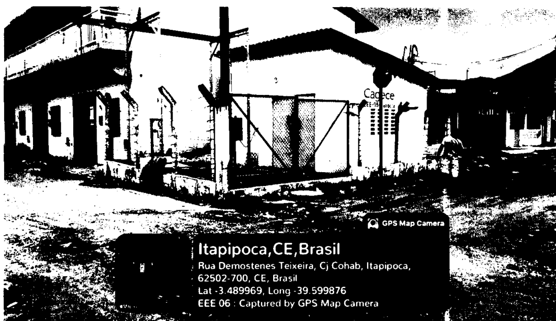
Figura 9 - Estação Elevatória de Esgoto – EEE 06 (EEE 05-Existente)
